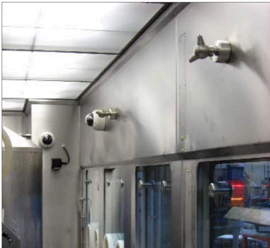
Рис. 16. Ротационные форсунки способствуют равномерному и быстрому распределению H_2O_2 на системе RABS (источник: Франц Циль)
